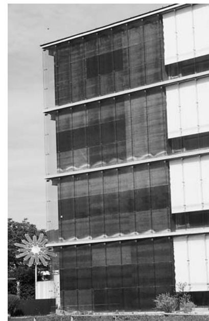
Schulhaus Mäder: Öffentliches Gebäude als Passivhaus
