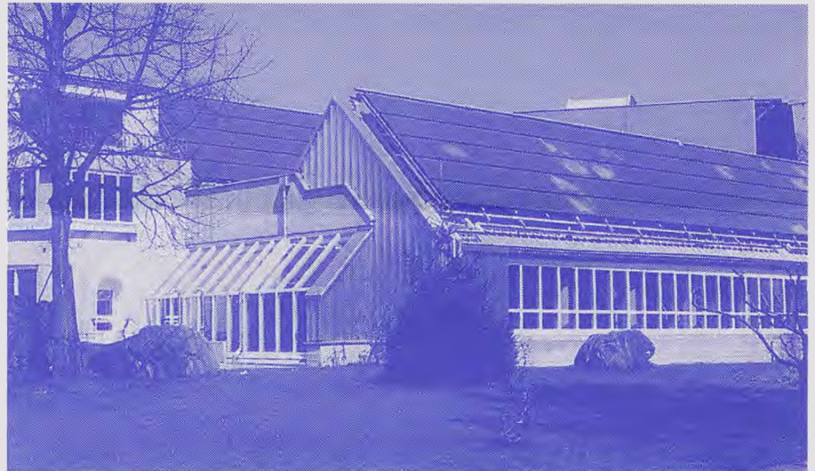
Schul- und Sportzentrum Eschen, 750 m 2 Sonnenkollektoren liefern Wärme für das Schulzentrum und das Schwimmbad – Jahresertrag 400 MWh
