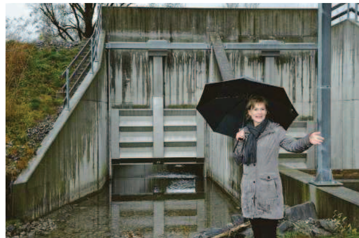
Monika Gstöhl (LGU) vor dem Auslaufbauwerk.
