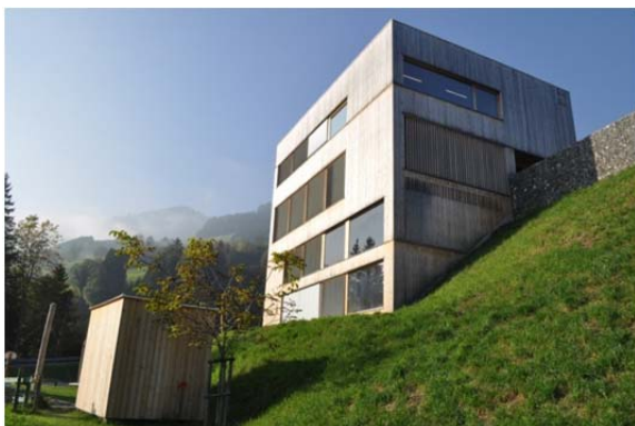
Gemeindezentrum St. Gerold – modernes Multifunktionsgebäude aus lokalem Holz. © Caroline Begle, CIPRA International
