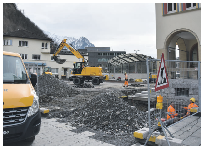
Derzeit regieren die Bagger auf dem Vaduzer Rathausplatz. (Foto: D. Fritz)
